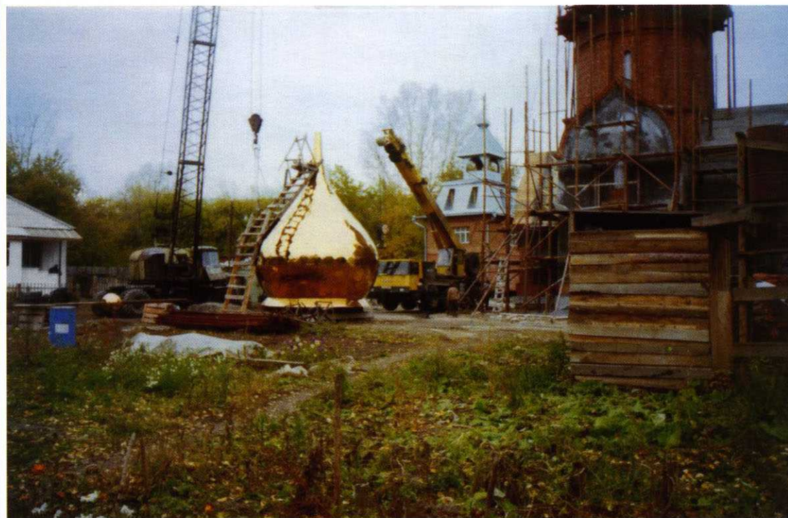
Подготовка купола к поднятию, 2000 г.
