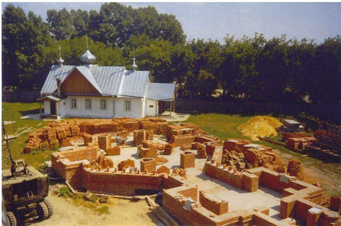
Начало строительства каменного храма, август 1999 г.
