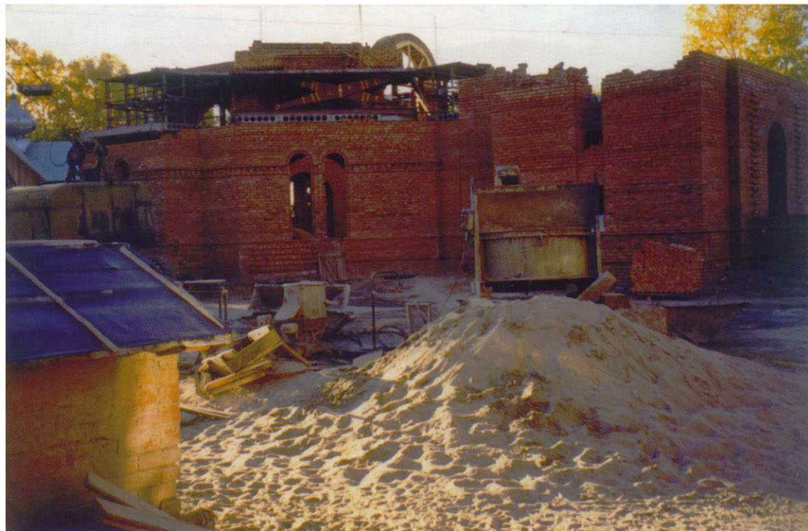
Строительство храма, осень 1999 г.
